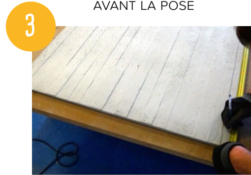
APPLIQUER LES MESURES SUR LE PANNEAU
